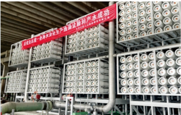
天津南港工业区海水淡化及综合利用一体化项目一期首条生产线
