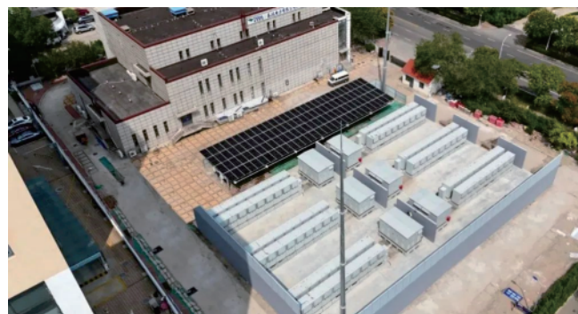
46.9兆瓦时电网侧电化学储能电站项目
